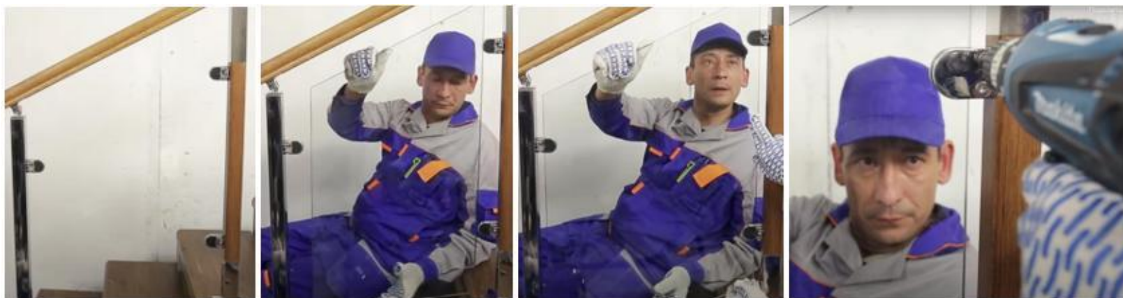
Рисунок 2.6 – Зачистка сварных швов углошлифовальной машинкой
