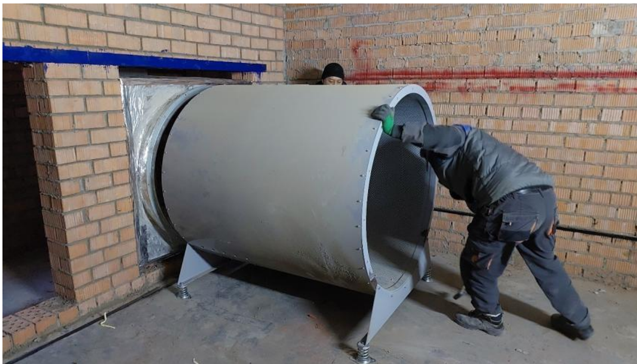
Рисунок 8 – Установка вентилятора в проектное положение
