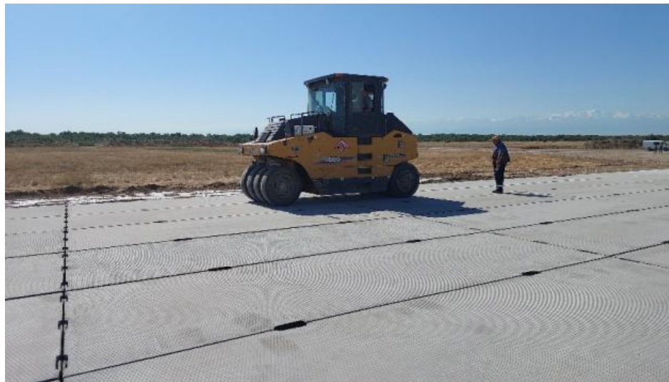
Рисунок 5 – Прикатывание плит
