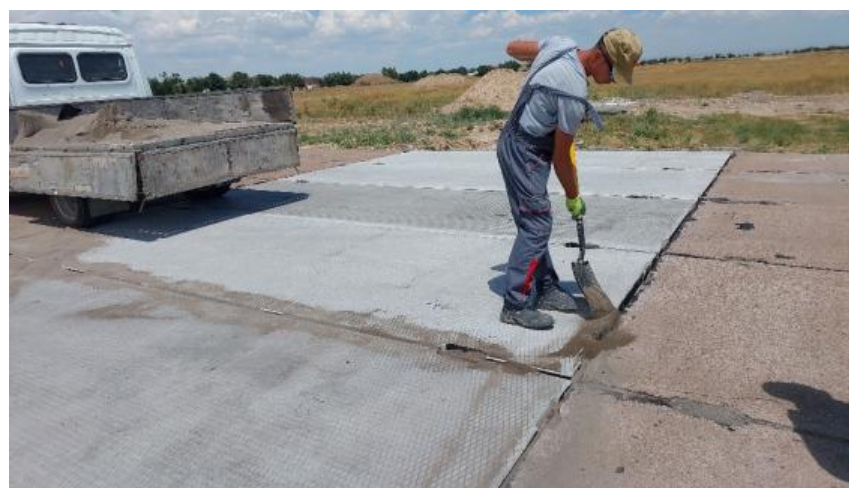
Рисунок 8 - Заполнение швов цементно-песчаной смесью
