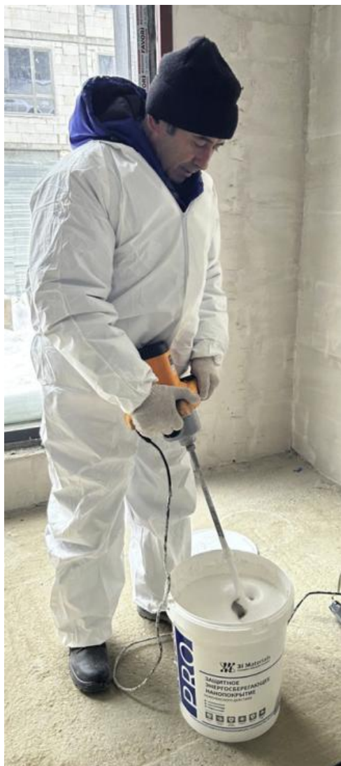
Рисунок 2.1 – Наладка оборудования безвоздушного распыления и приготовление материала а – приготовление материала, б – наладка оборудования безвоздушного распыления, в – установка материала в оборудование
