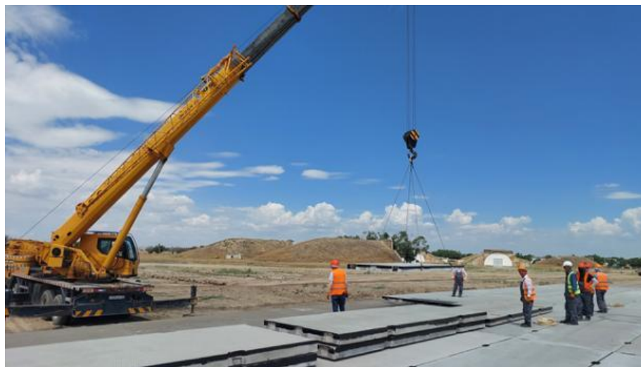
Рисунок 4 – Укладка дорожных плит
