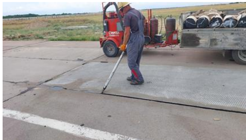
Рисунок 9 - Герметизация швов битумно-полимерным герметиком
