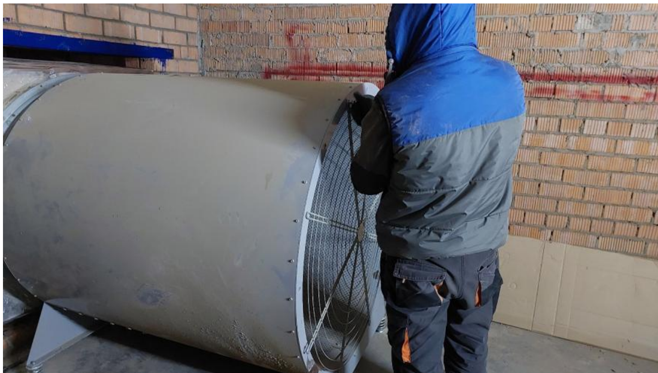
Рисунок 12 – Установка проволочного сепаратора
