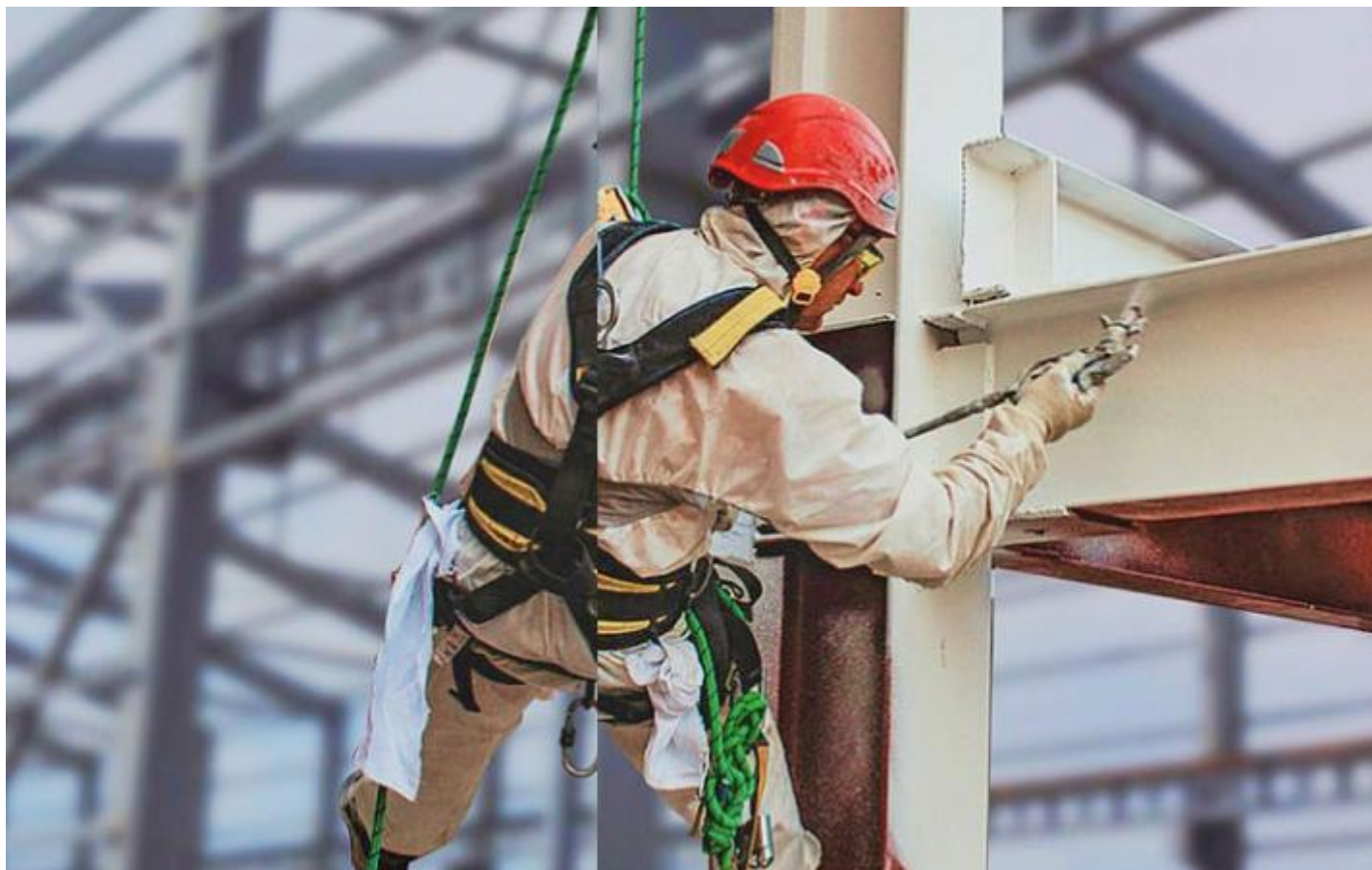
Рисунок 2.4 – Нанесение нанопокрyтия на металлоконструкции
