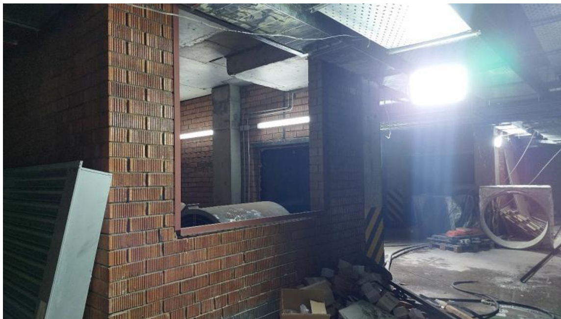
Рисунок 3 - Проем под установку клапана
