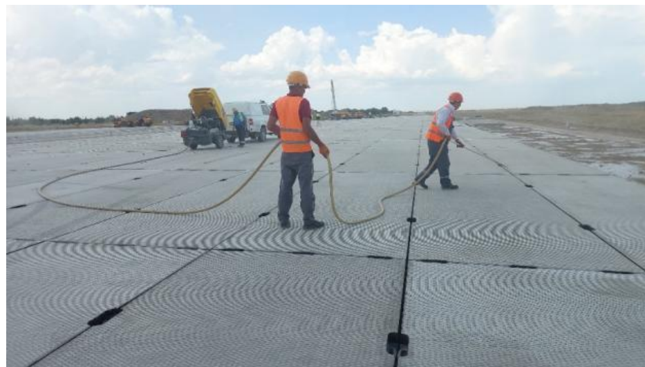
Рисунок 6 – Очистка поверхности и швов плит
