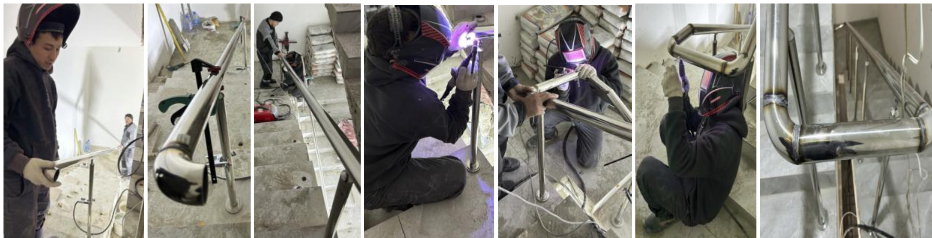
Рисунок 2.3 – Установка поручней
