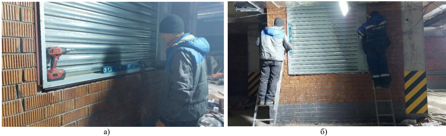
Рисунок 5 – Процесс крепления клапана к основанию
