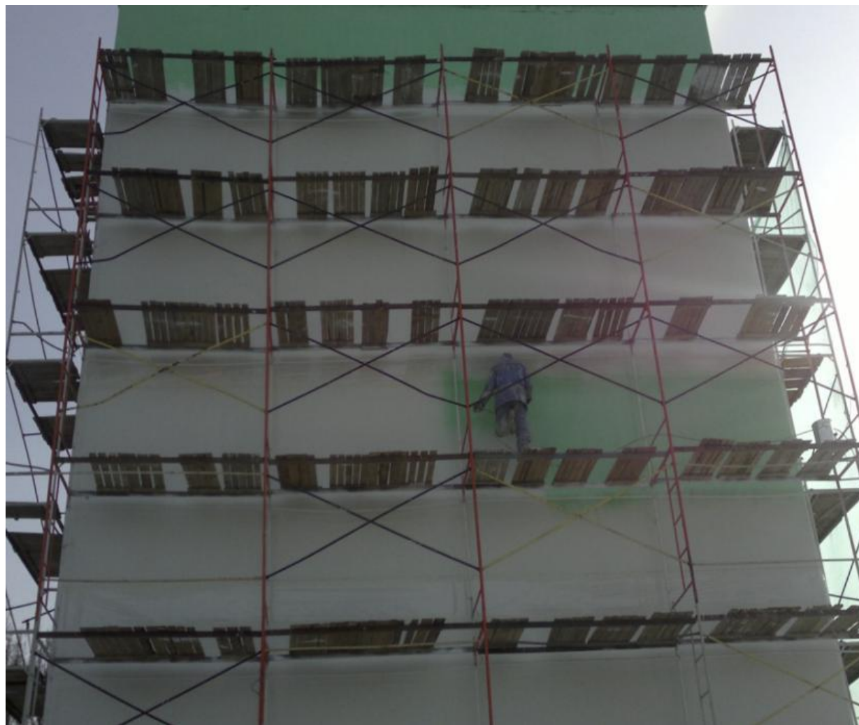
Рисунок 2.2 – Нанесение нанопокрытия на стены
