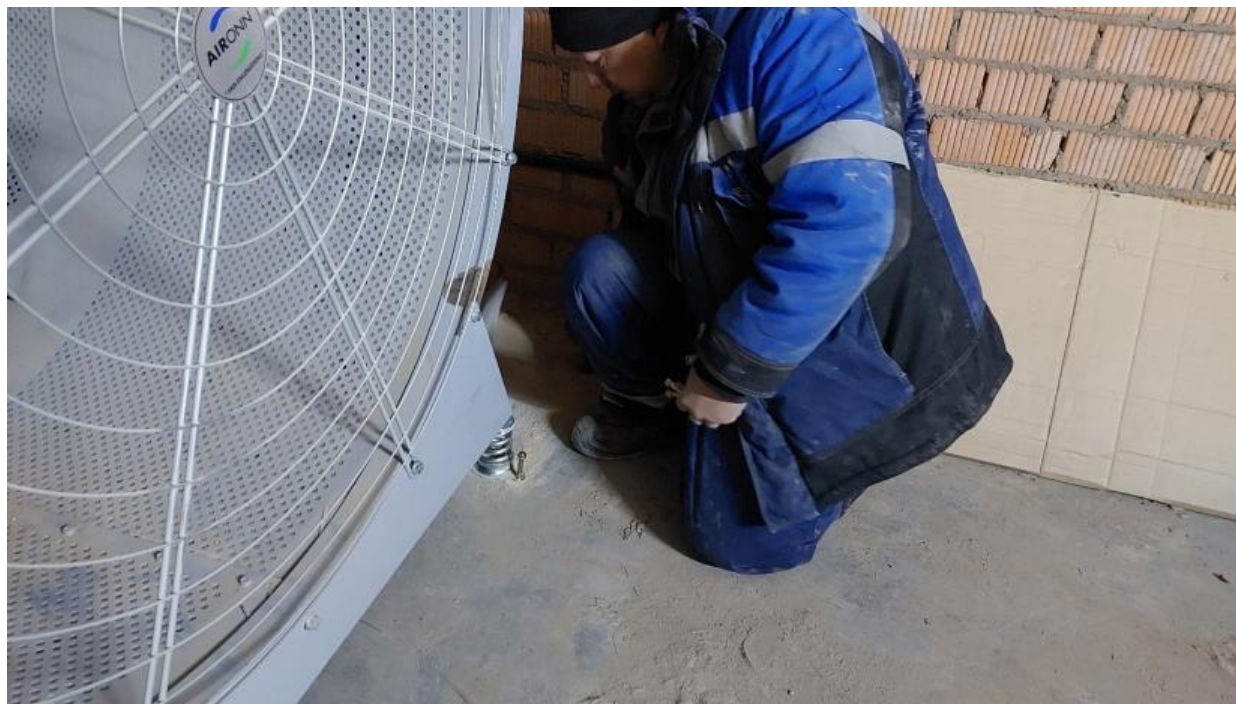
Рисунок 11 – Крепление вентилятора к основанию
