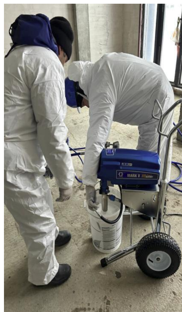
Рисунок 2.1 – Наладка оборудования безвоздушного распыления и приготовление материала а – приготовление материала, б – наладка оборудования безвоздушного распыления, в – установка материала в оборудование
