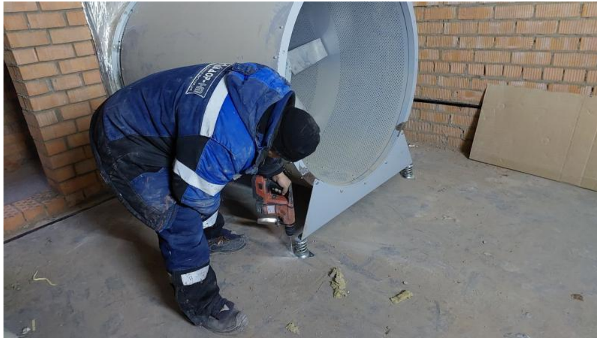
Рисунок 10 – Сверление основания для крепления вентилятора
