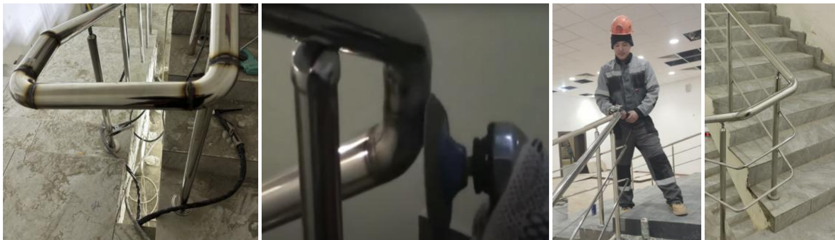
Рисунок 2.6 – Зачистка сварных швов углошлифовальной машинкой
