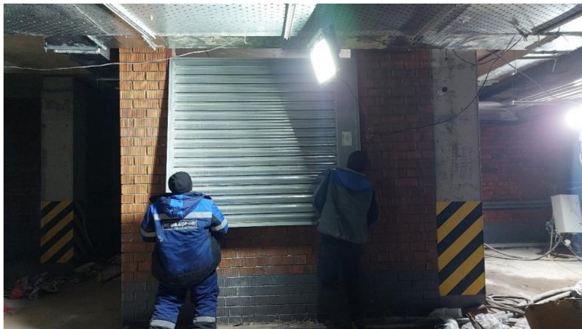
Рисунок 4 - Установка клапана в проектное положение
